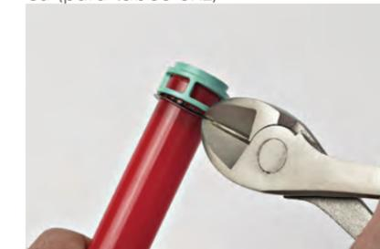
**3** Retire a anel de fixação do tubo, com um alicate de corte. (para tubos 20x2)
